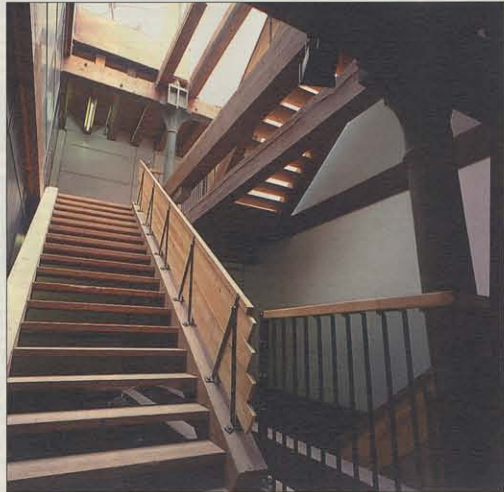
Van links naar rechts: het trappenhuis van het Veem, ontworpen door Jaap den Baars. De treden zijn gezagd uit gesloopte balken uit het Veem, de leuning zijn gemaakt door beeldhouwer Barten van Elden
